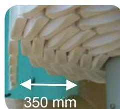
⚠ Pensez à disquer vos margelles afin d'éviter le frottement de la couverture lors de l'ouverture et de la fermeture du volet.
